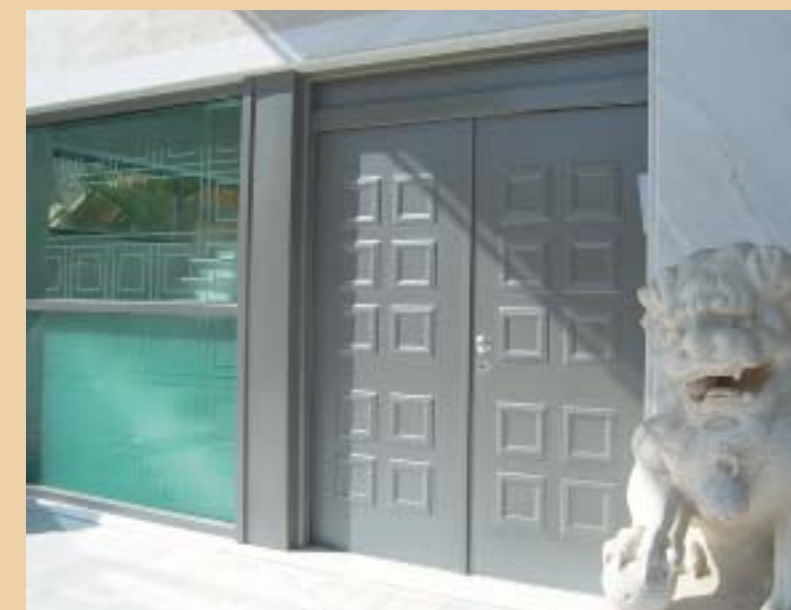
Κεντρική Είσοδος Δίφυλλη CAVO (ηλεκτρονική κλειδαριά). Επενδύσεις ALUMINIO 26000 RAL 9007
